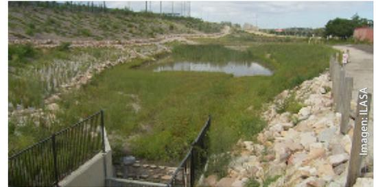
**Estanques de atenuación** – La construcción de estanques para almacenar e infiltrar el caudal de los ríos y el escurrimiento de las aguas pluviales.
