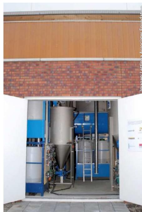
Sistema de tuberías para el proyecto piloto de DeSAR en Sneek, Países Bajos, donde 32 casas han tenido el sistema instalado.
